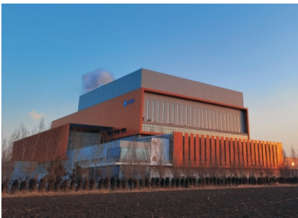
辽宁鞍山环保发电厂 (1500吨/天)
