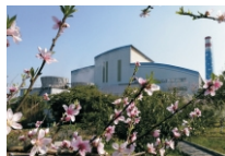
重庆同兴环保发电厂 (1200吨/天)
