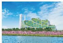
安徽六安环保发电厂 (1200吨/天)
