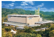
重庆丰盛环保发电厂 (2400吨/天)
